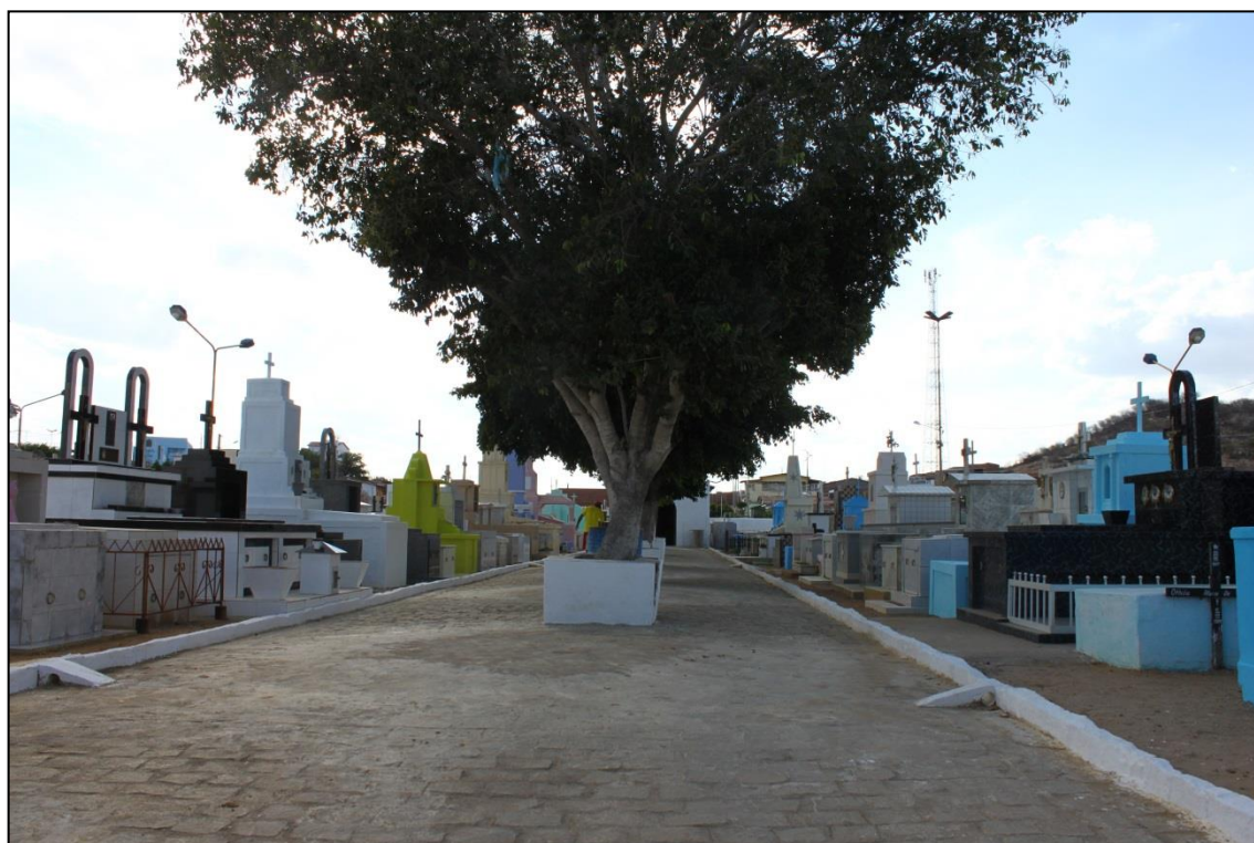
Figura 3.3.7.4.2 – Cemitério Central de Picuí.
