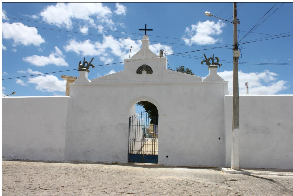
Figura 3.3.7.4.1– Cemitério Central de Picuí.
