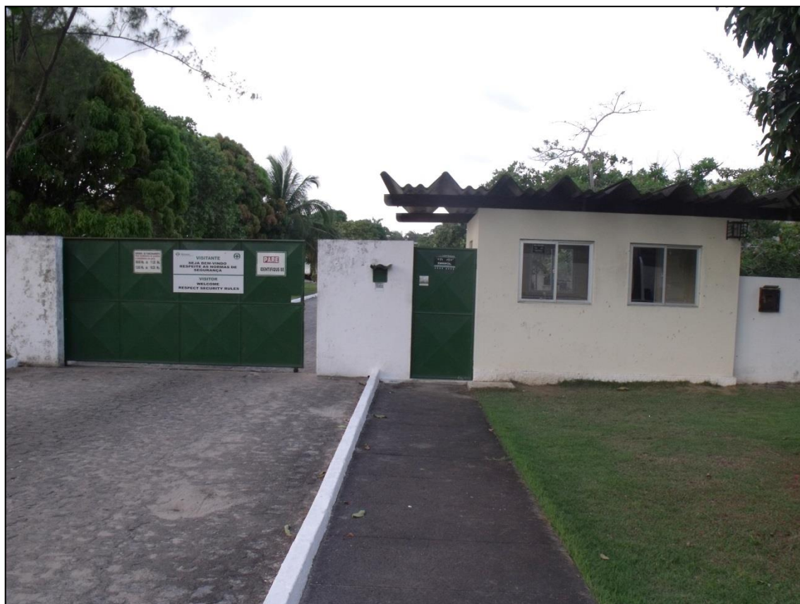
Figura 2.1.4.2.1- Prédio da Stericycle – João Pessoa/PB.
