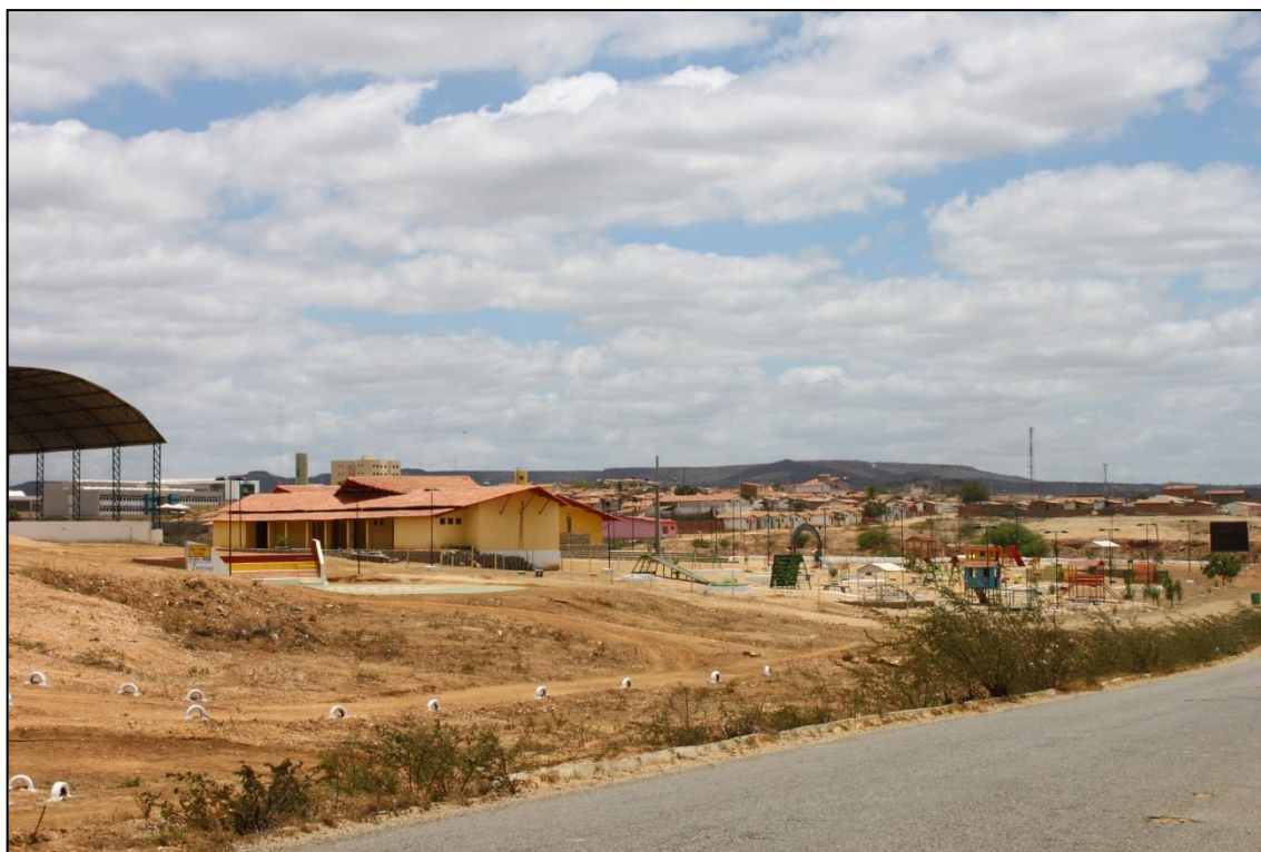
Figura 5.1 - Vista parcial do primeiro local onde funcionava o antigo lixão da cidade.
