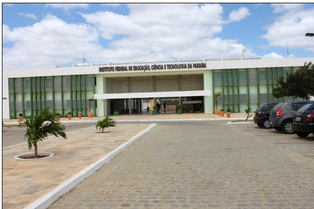
Figura 6.1 – Instituto Federal de Educação da Paraíba – Campus Picuí.
