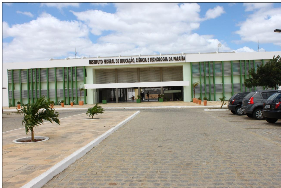
Figura 2.1.3.1.5 – Instituto Federal de Educação da Paraíba – Campus Picuí.
