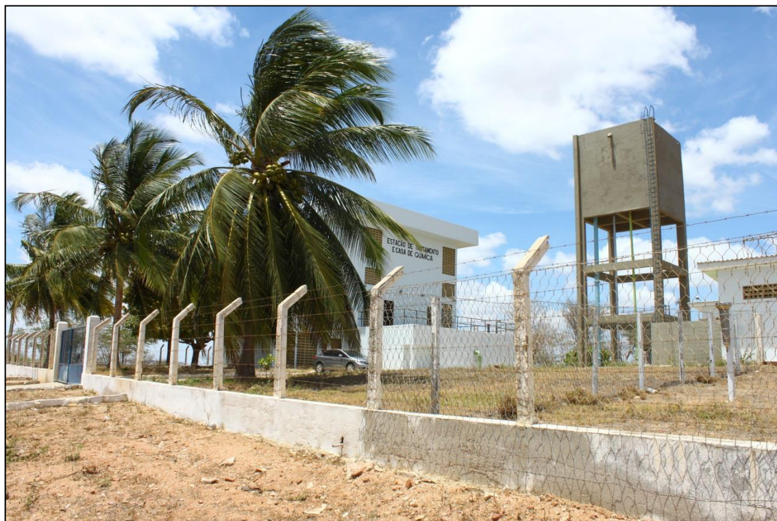
Figura 2.1.4.1.2– Estação de Tratamento de Água.
