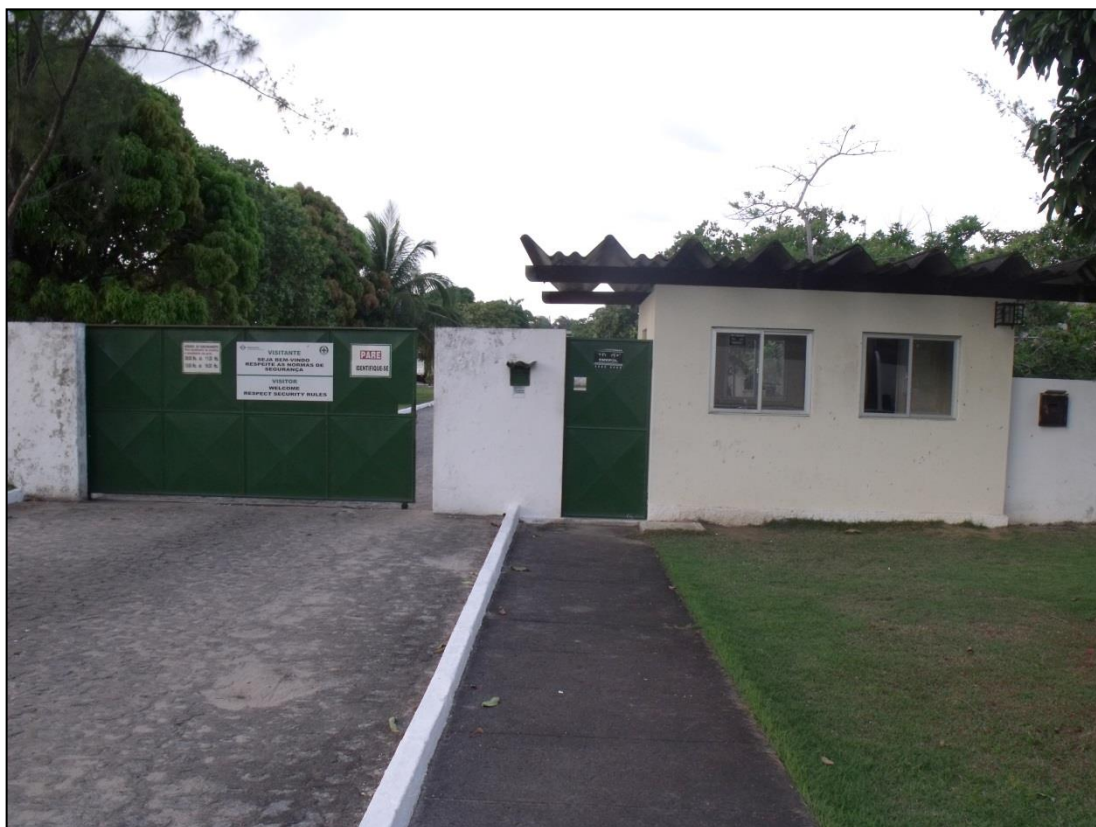
Figura 3.3.5.2 – Prédio da Serquip – João Pessoa/PB.
