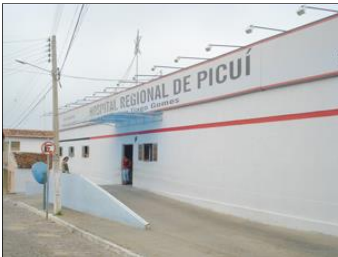
Figura 2.1.3.2.3.– Hospital Regional de Picuí.
